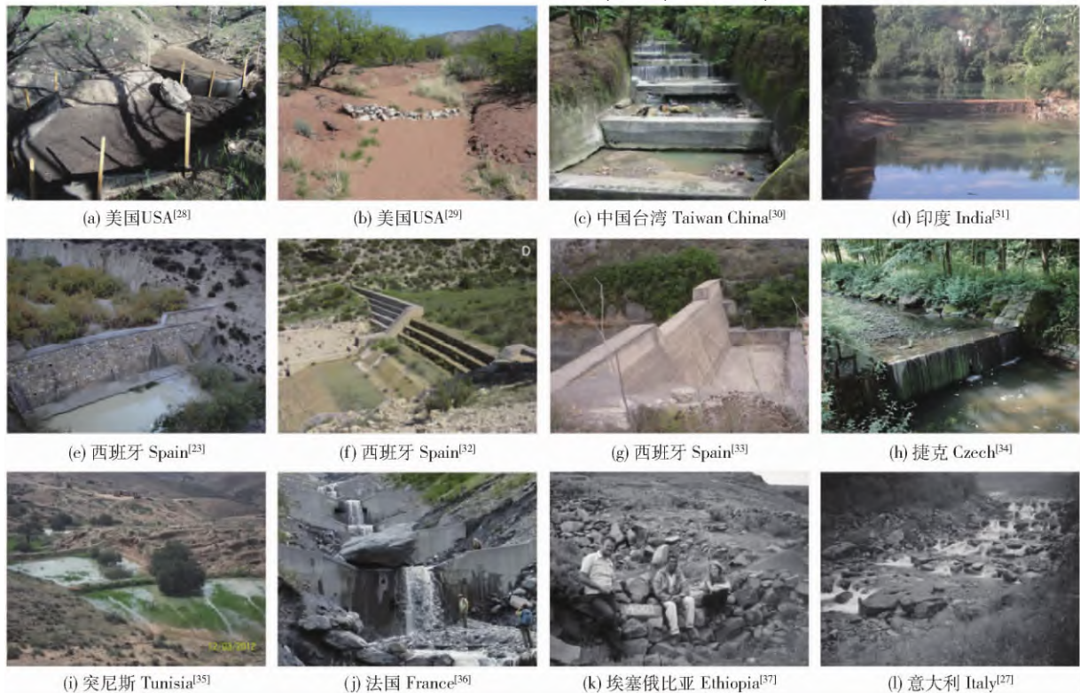
图 2 Check dams 景观图
