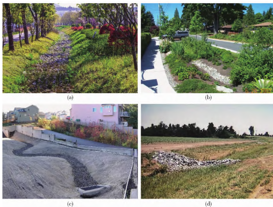
图 1 美国 check dam 常作为植被过滤带
