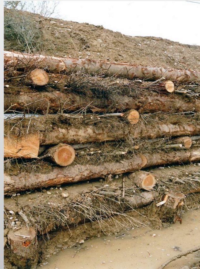
Einwandige Holzstruktur aus Larix decidua gefällt in Höhenlagen der Pyrenäen
