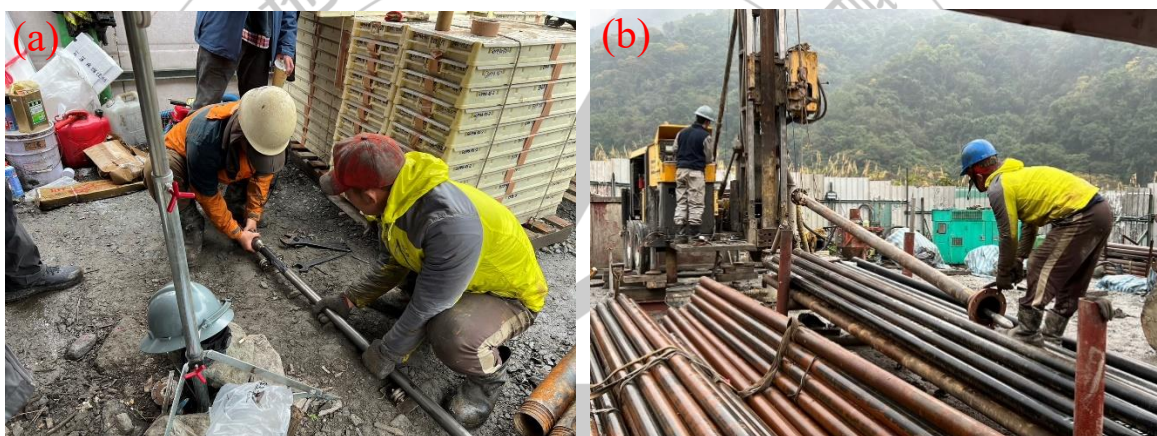
圖 4-5 (a)測棒組裝；(b)將測棒放入防噴管內並吊放至井頭
